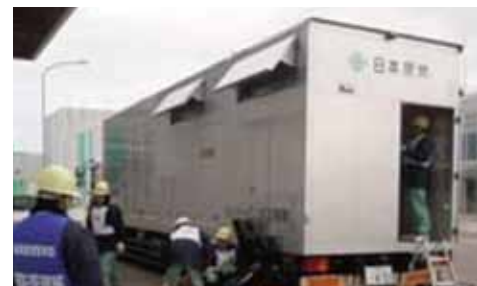
電源車から電力を供給する訓練
