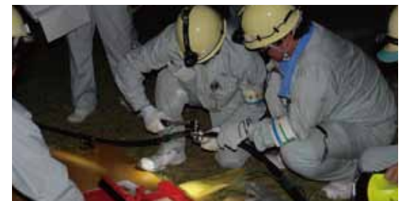
ヘッドライトの灯りで電源ケーブルを接続する訓練(夜間)
